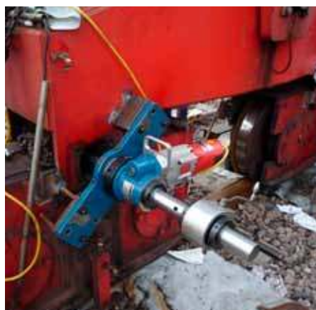
↑ Mobile Spindelarbeiten an Kranfahrwerken
