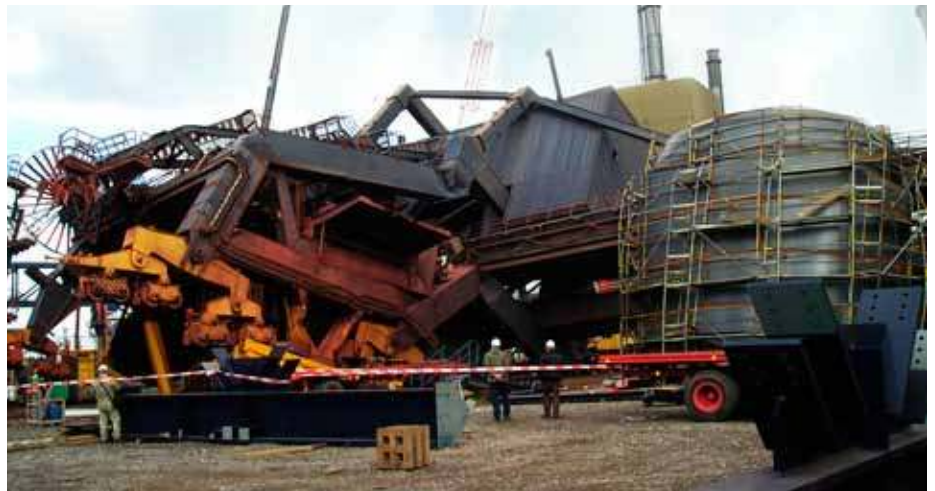
↑ Reparatur einer Krananlage: Vorher
