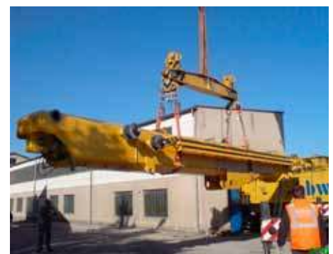
↑ Teleskopausleger-Zylinderaustausch
