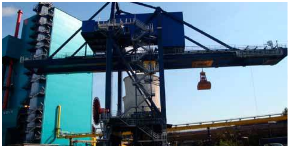
↑ Reparatur einer Krananlage: Nachher
